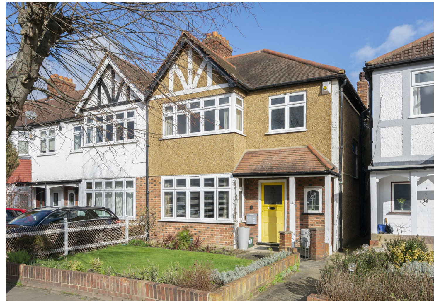
32 Aylward Road, Merton Park, SW20 9AF
